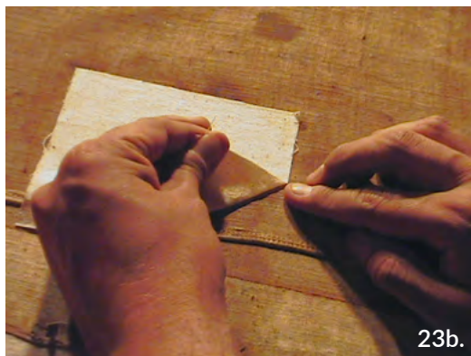
Figs. 23a y 23b. Eliminación de parches colocados en intervención de 2006.
