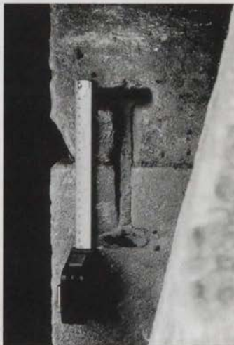
Figura 12. Grapa arquitectónica de la pirámide de Pumapunku, Tiwanaku, Bolivia. La grapa, de aproximadamente 19 cm de largo, está in situ , en la unión de dos bloques de piedra del muro del canal sur del montículo del templo. Se fabricó vertiendo el metal derretido en una depresión tallada en ambos bloques.
