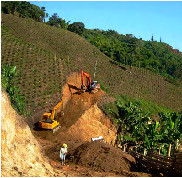
Fig. 5. Construcción de la carretera perimetral oriental en pendientes pronunciadas.
