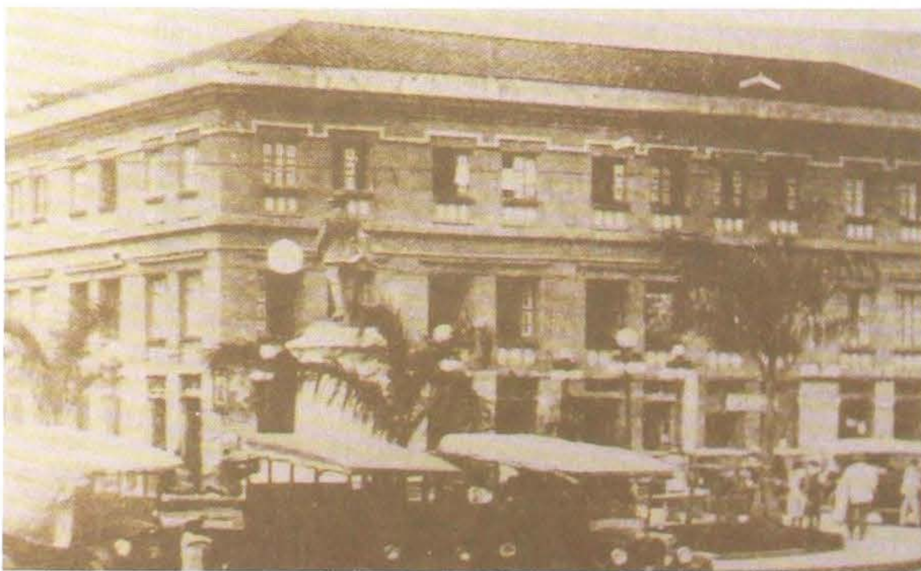
Edificio Vásquez, reformado y reconstruido después del incendio de 1912. ca1920.
