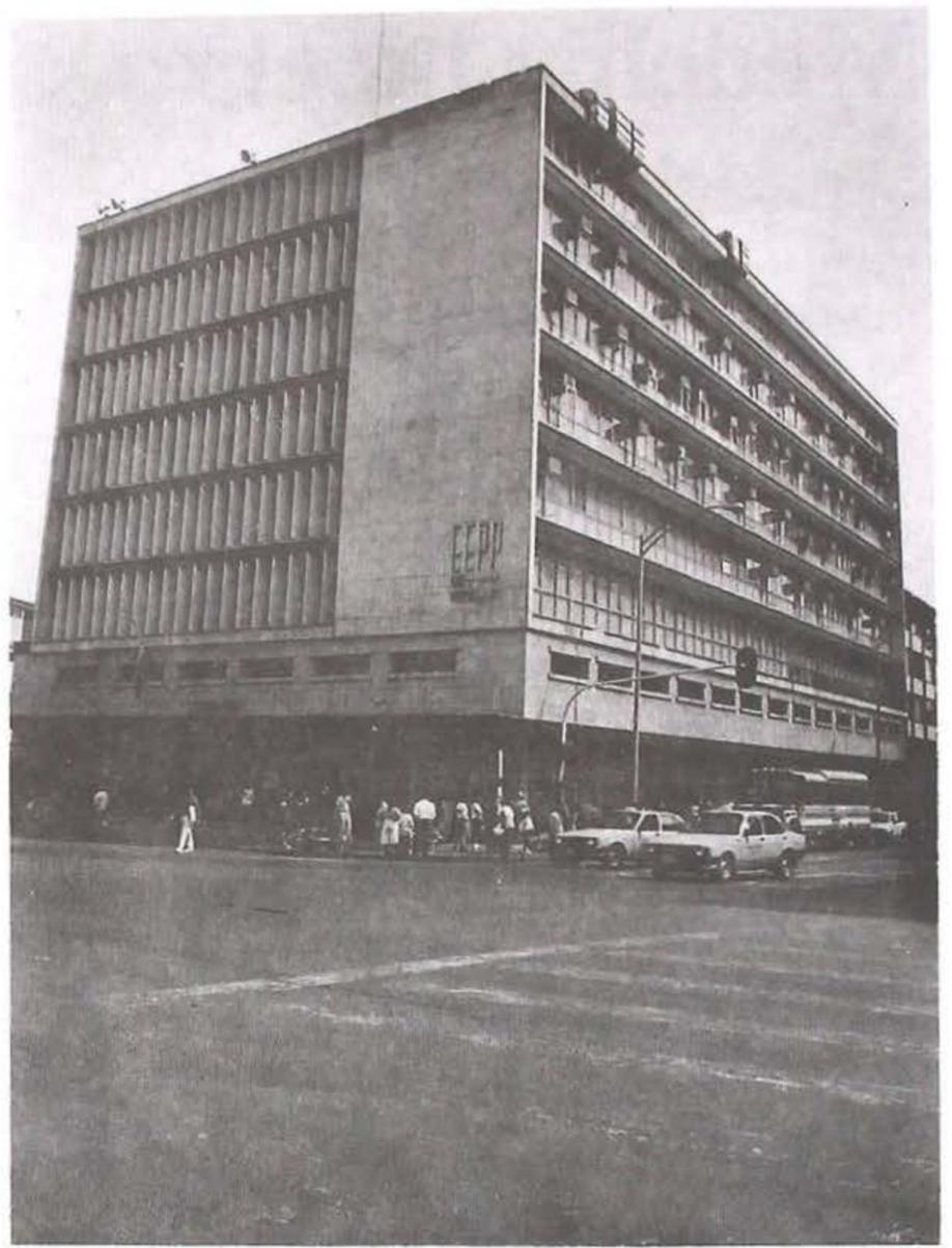
Edificio Miguel de Aguinaga (1956), Carabobo con avenida De Greiff, A. González. Protecciones solares verticales en concreto en la fachada sur y ventanas profundas en la fachada oriental.
