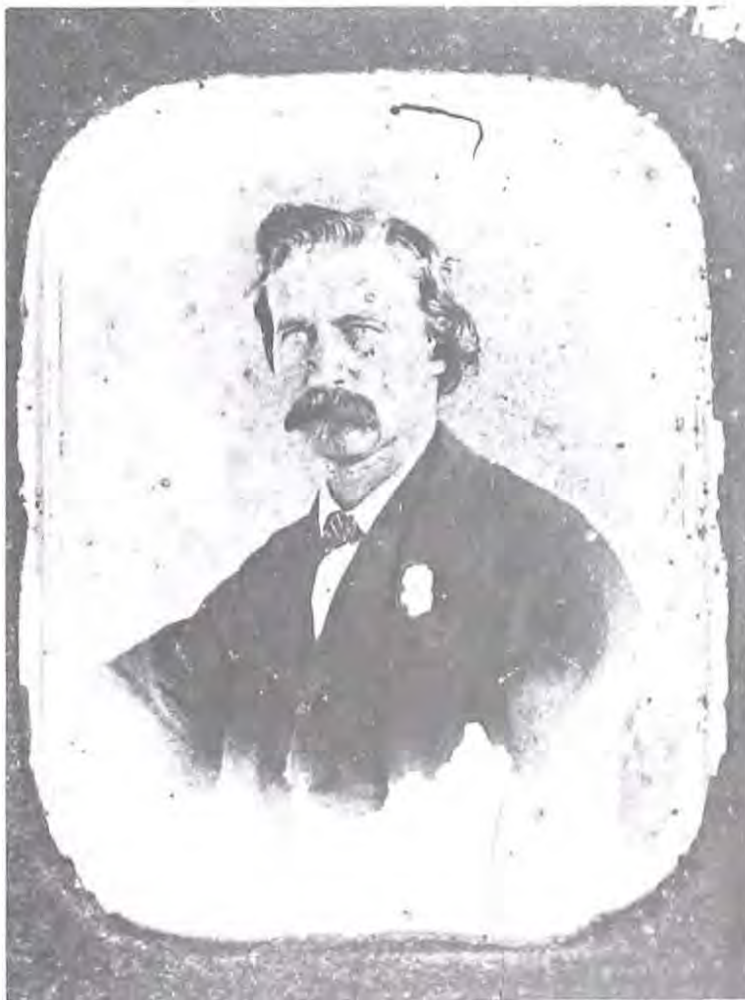
Geo von Lengerke llega a Zapatoa en 1852
