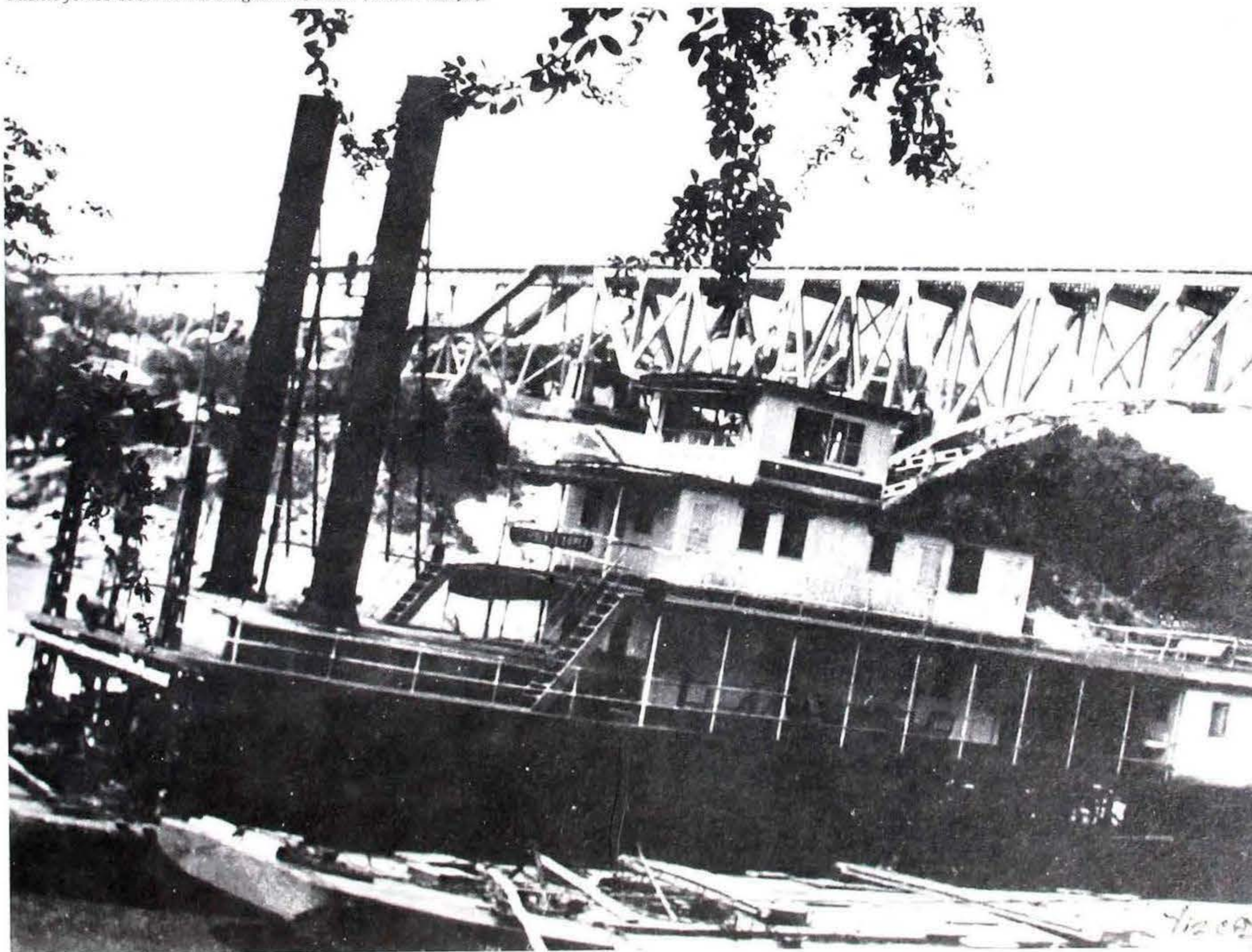
Puente férreo sobre el río Magdalena, 1963. (Foto Vizcaya).
