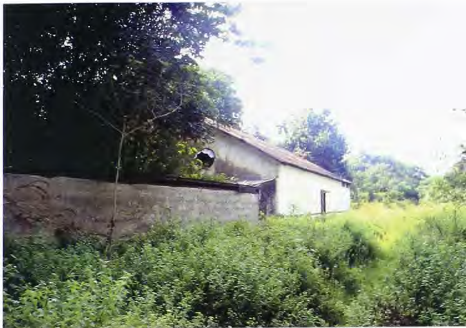
Aspecto de una de las bodegas del ferrocarril.
