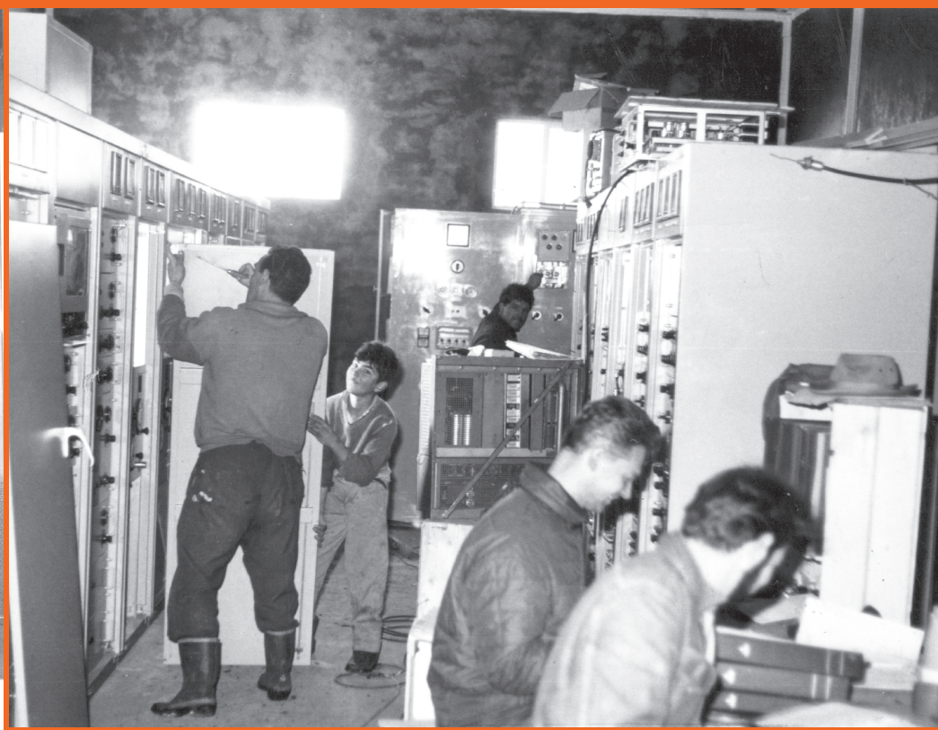
En el municipio de Ábrego (Norte de Santander) se instaló la estación Jurisdicciones que recibía la transmisión del nevado del Ruiz y fue el enlace por bandas de alta frecuencia (VHF) más extenso del mundo (400 km).
