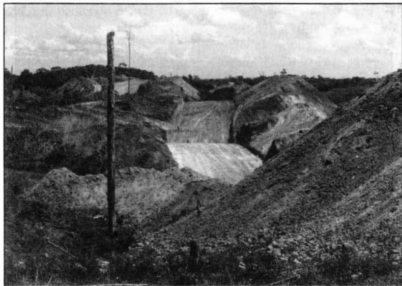
Lámina 3. Apertura del derecho de vía en sector de colinas cerca al km. 95 (Nótese la magnitud de remoción de tierra).
