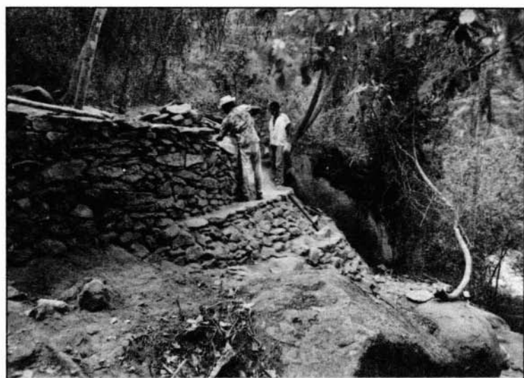
Estado avanzado de restauración, en el que se puede apreciar que este muro de contención está constituido exclusivamente por rocas graníticas, con una estructura conformada por tres contramuros, los dos inferiores con una inclinación aproximada de 50°, mientras que el superior es prácticamente vertical.
