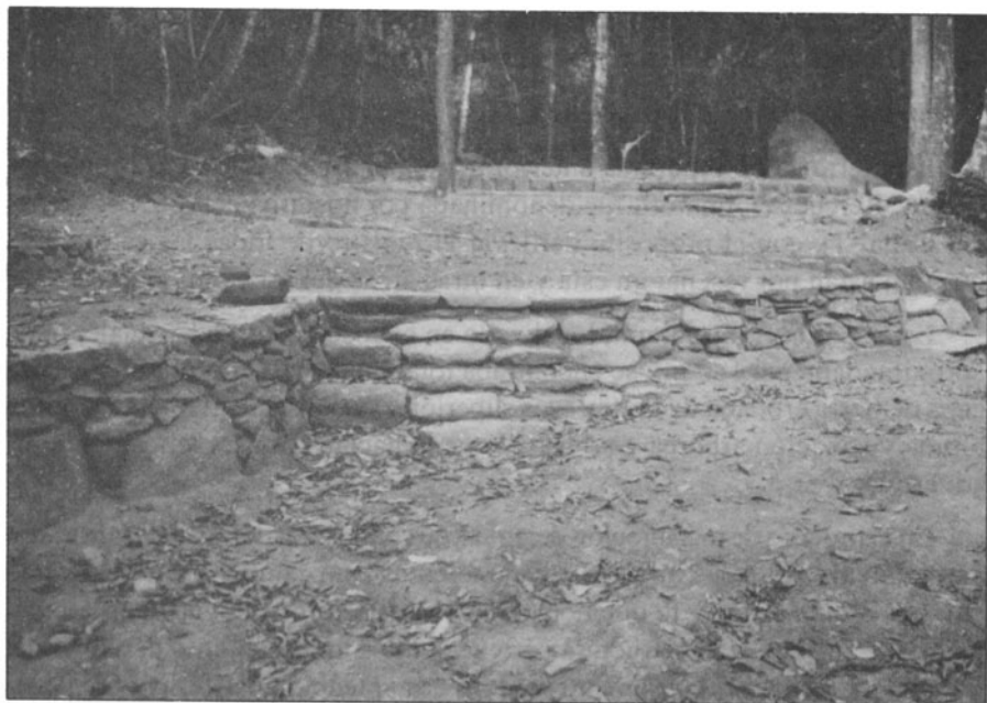
Terraza XXXV, en la que podemos observar la estructura anular correspondiente a la vivienda y una de las escaleras de acceso a la Terraza XXXIV.
