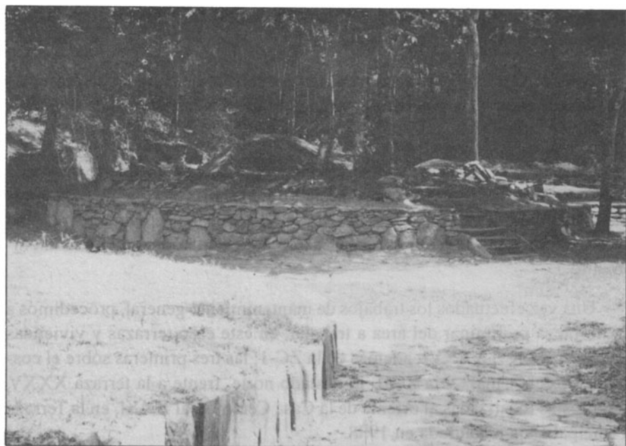
Aspecto general de la Terraza XXXIV, en estado avanzado de restauración. Se observa la composición del muro, en que se alternan las lajas verticales y horizontales, tendientes a proporcionar estabilidad a la obra.
