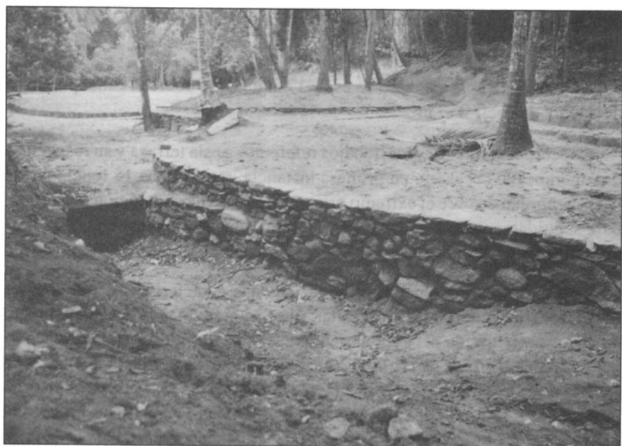
Muro de contención de la Terraza XXXIV, que como se puede observar, lo es también en esta sección, muro de la canalización. A la izquierda se aprecia el inicio del "canal" subterráneo que se dirige a la quebrada de Las Lajas atravesando la Terraza Principal Baja del asentamiento.
